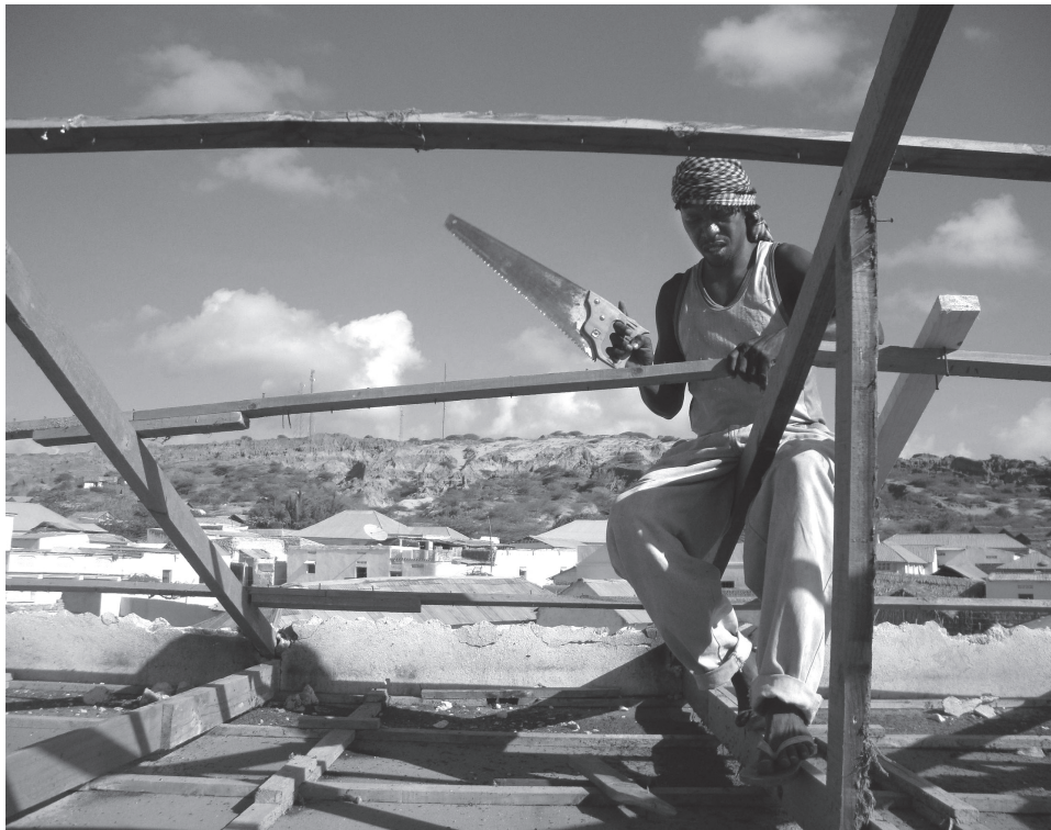
Renovation des Sekundarschulhauses im somalischen Ambe Banaan. Bild: Heinrich Frei.
