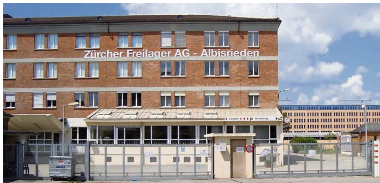
Auf dem Areal des Zollfreilagers in Albisrieden entstehen über 800 neue Wohnungen.
